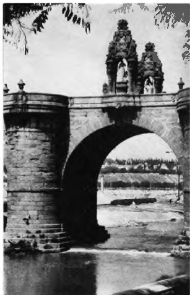
Puente de Toledo. Detalles.
