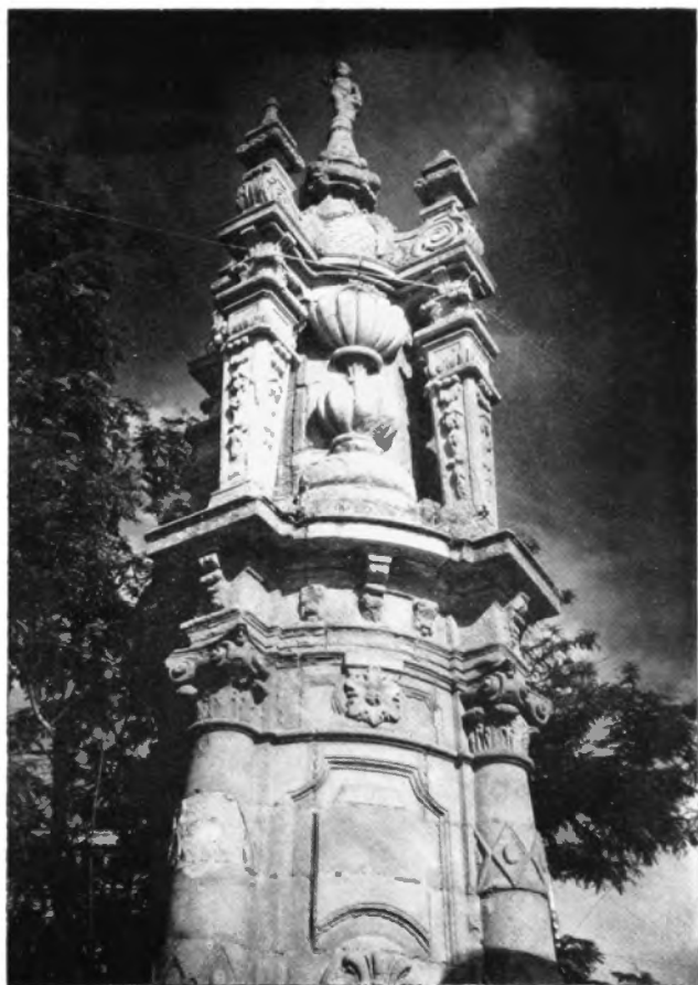
Puente de Toledo. Torrecilla ornamental. (Foto F. de la Maza).
