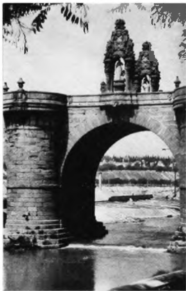
Puente de Toledo. Detalles.
