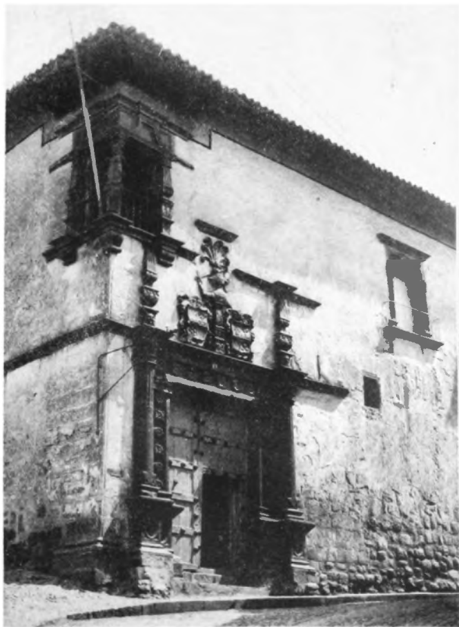
Fachada de la Casa del Almirante.
