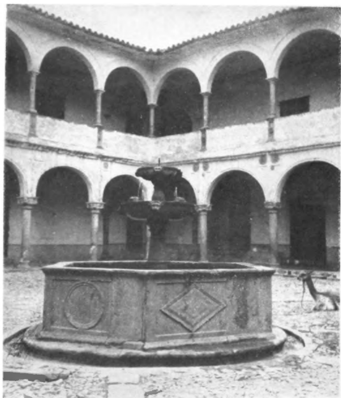
Patio principal con la gran fuente de agua.
