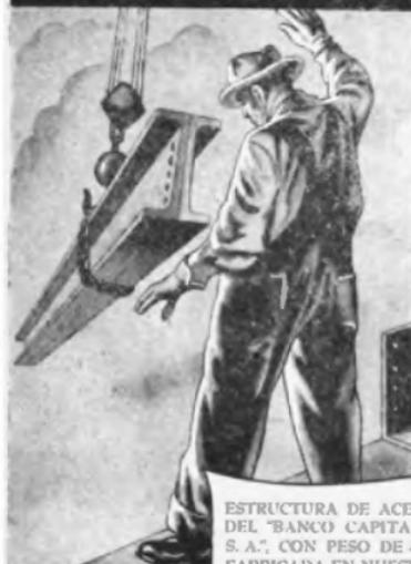
ESTRUCTURA DE ACERO PARA EL EDIFICIO DEL "BANCO CAPITALIZADOR DE AMERICA, S. A.", CON PESO DE 895 TONEJADAS, FABRICADA EN NUESTRA PLANTA DE MONTERREY, CON PERFILES ESTRUCTURALES PRODUCIDOS POR NOSOTROS MISMOS. ESTE EDIFICIO FUE CONSTRUIDO POR LOS INGENIEROS Y ARQUITECTOS MARTINEZ-NEGRETE, EN LA ESQUINA DE LA AVENIDA JUAREZ Y LUIS MOYA, DE LA CIUDAD DE MEXICO.
