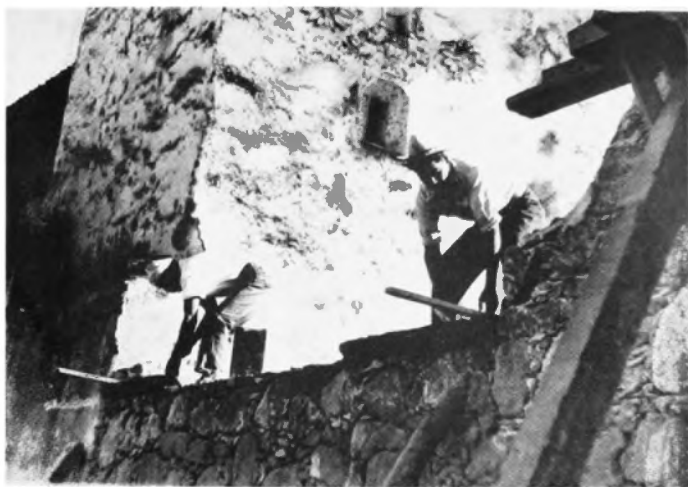
Miembros de la comunidad de Opopeo construyen letrinas para la escuela.
