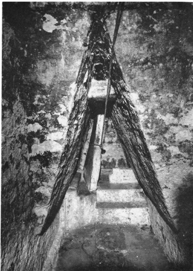
Detalle de la entrada de la cámara en el momento en que se retiraba la placa de piedra que la cubría.
