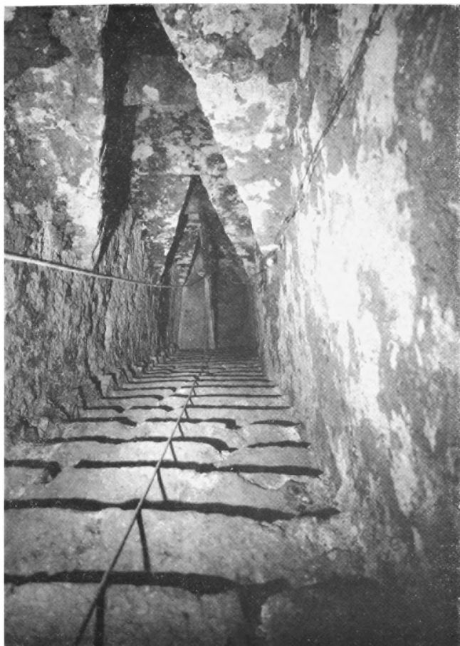
Vista del segundo tramo de escalera en el que se puede apreciar la bóveda que la cubría después de que fué retirado el relleno de piedra, arcilla y cal.
