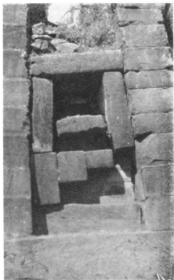
Foto 2.—Vestigios originales del arranque de la alfarda sureste.
