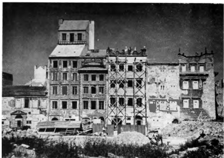
Trabajos de reconstrucción en el mercado viejo de Varsovia. Famosos edificios medievales destruidos sistemáticamente por los nazis.
