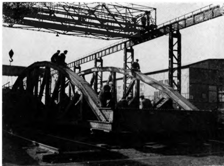
Montaje de un puente de acero en una fábrica de Silesia.
