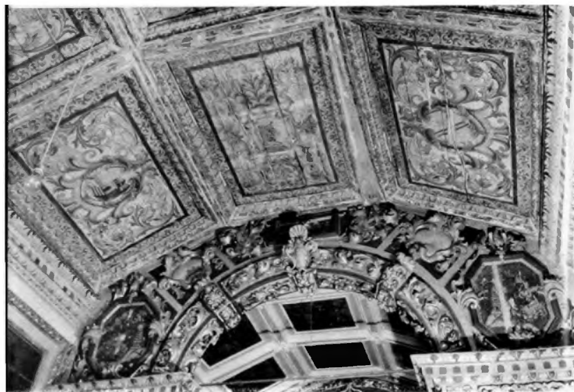
Pintura del forro en "caixotões" de la iglesia de Sabará.
