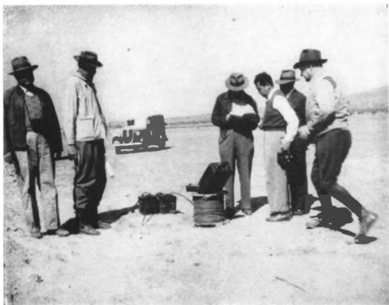
Fig. 2.—*Arriba*: Determinando líneas equipotenciales. Sundberg en el centro con el aparato receptor (radio y audífonos). *Abajo*: Aparato transmisor para la determinación de líneas equipotenciales (dos acumuladores de auto conectados a un interruptor y éste a dos electrodos que son dos alambres de 600 m. de largo).
