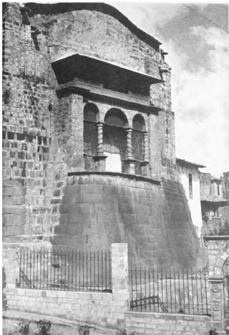
Cusco. Sto. Domingo sobre los muros del Templo del Sol.
