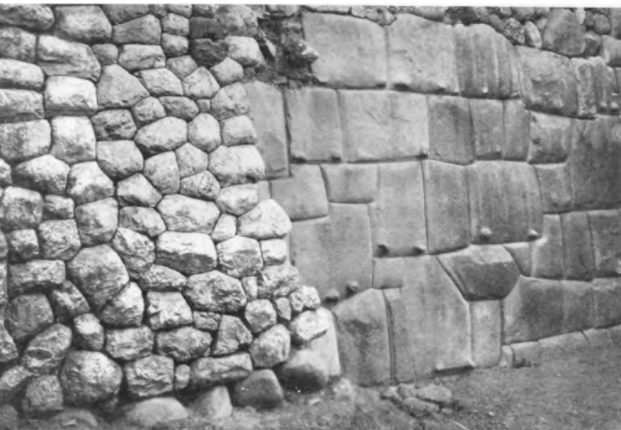
Un muro sobre otro, de diferente aparejo, ambos incaicos.
