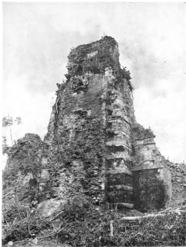
Parte del edificio de Xpuhil, Quintana Roo, mostrando una de las altas torres.
