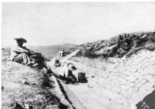
Fig. 4.—Escalinata exterior sur y corredor. Vista desde E. S. E. La alfarda del primer término es la S. E. consolidada en 1942.
