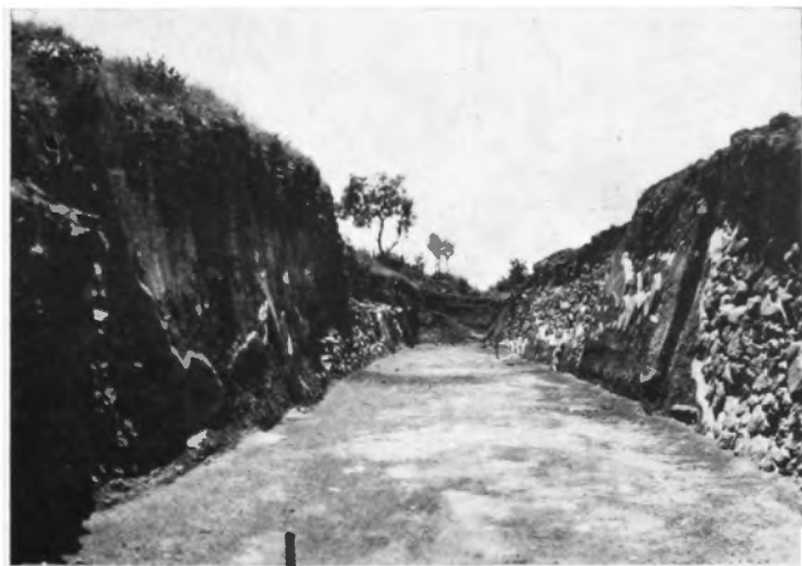
Teotihuacán. Callejón afluente a la Calle de los Muertos, que limita lateralmente al edificio explorado.
