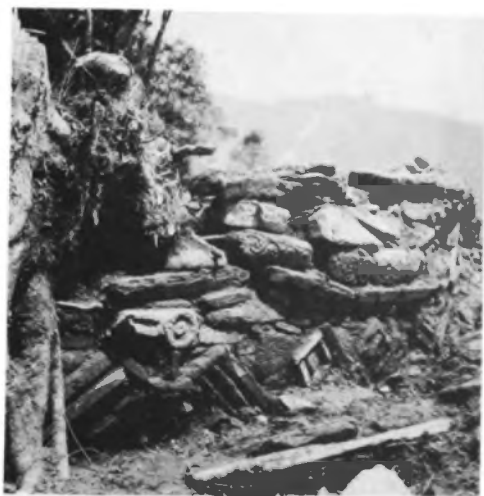
Edificio N° 2, muestra ave y cornisa con piedras ornamentadas.
