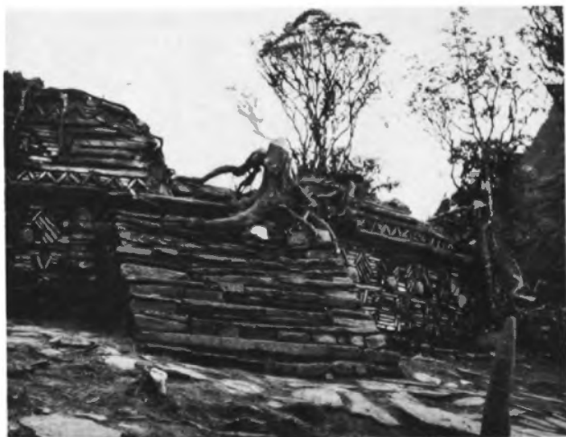
Edificio N° 1, terminada la limpieza y tala de árboles.
