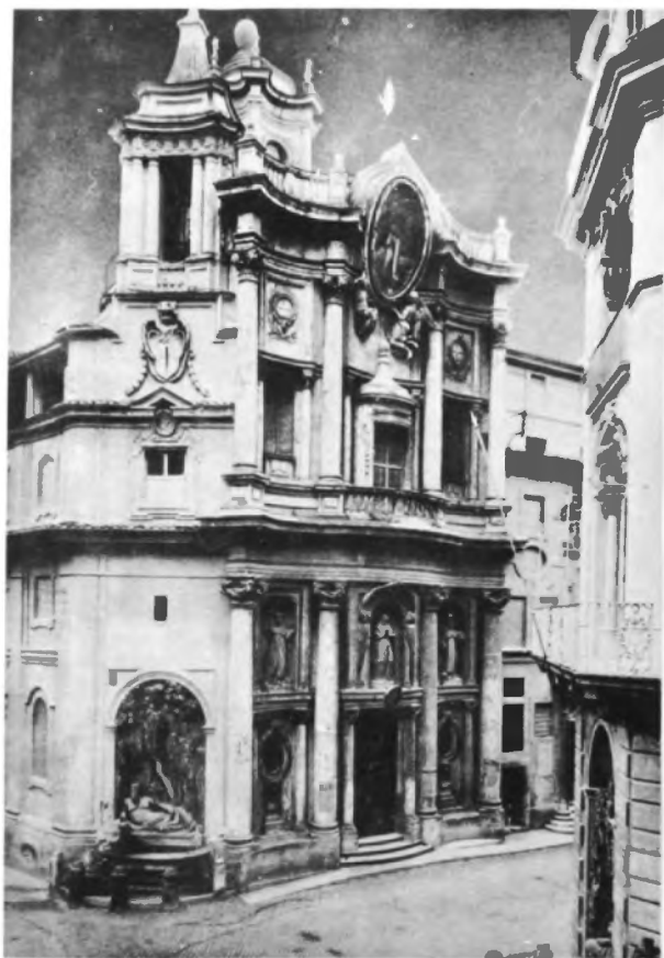
Iglesia de San Carlo en la calle de Quattro Fontane, en Roma (Borromini, 1667).
