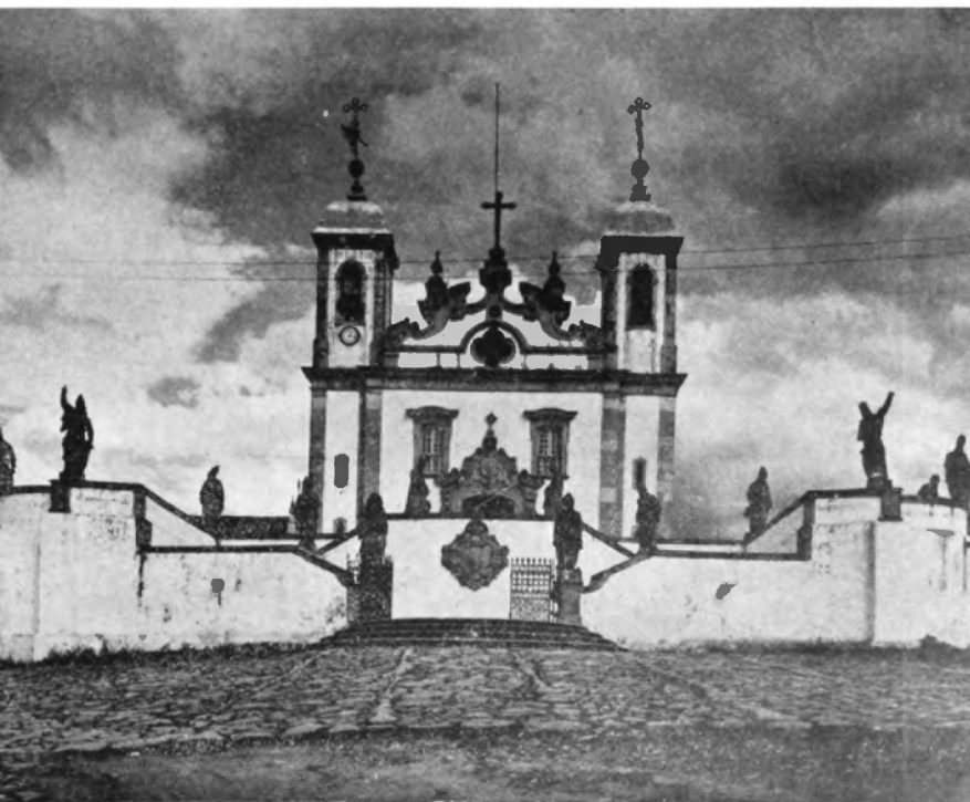
Iglesia de Nosso Senhor do Bom Jesus de Matosinhos, cuya construcción y esculturas son obra de O Aleixadinho. Congonhas do Campo, Minas Geraes. Brasil, 1777.
