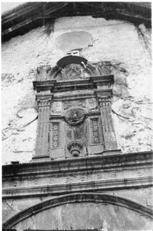
Remate de la fachada (detalle).
