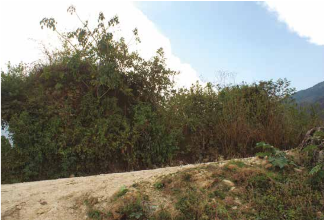
IMAGEN 48. Vista poniente de la iglesia (segmento norte del imafrente y la maleza donde estuvo desplantado el convento), Sibacá, 5 de abril de 2012. © Magdalena Vences.
